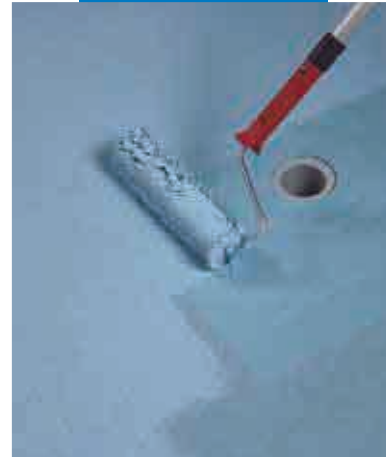
Mapelastic® AquaDefense 롤러로 방수재 2차 도포
