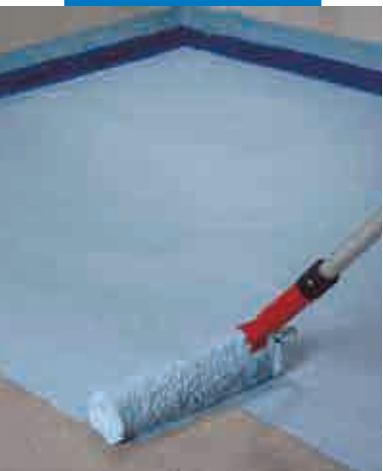
Mapelastic® AquaDefense의 미장 바닥면에 마페라스틱 아쿠아디펜스 1차 도포
