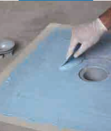
Mapelastic® AquaDefense로 배수구 수직 구조를 함침
