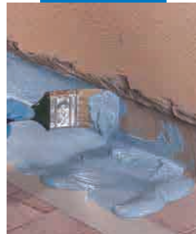
Mapeband 시공 전 바닥과 벽면 사이에 브러시로 Mapelastic® AquaDefense 도포
